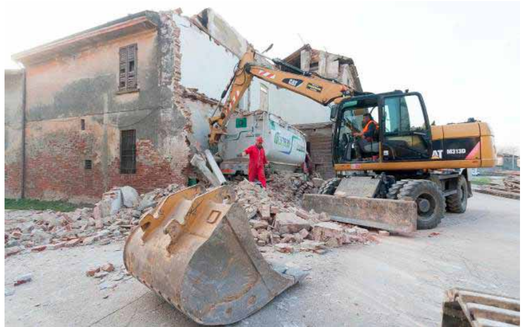
COM'È: il camion ieri pomeriggio, ancora dentro la parte di edificio ormai quasi completamente demolita
