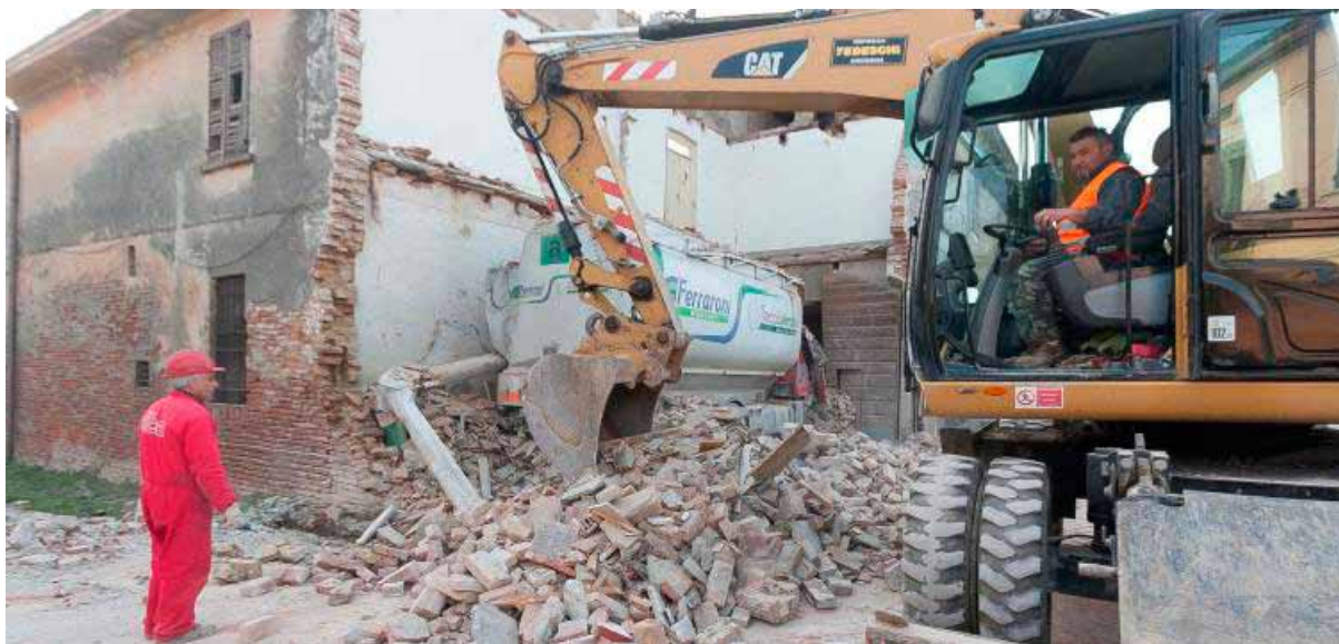
La ruspa in azione: dopo l'abbattimento si recuperano mattoni e tegole
