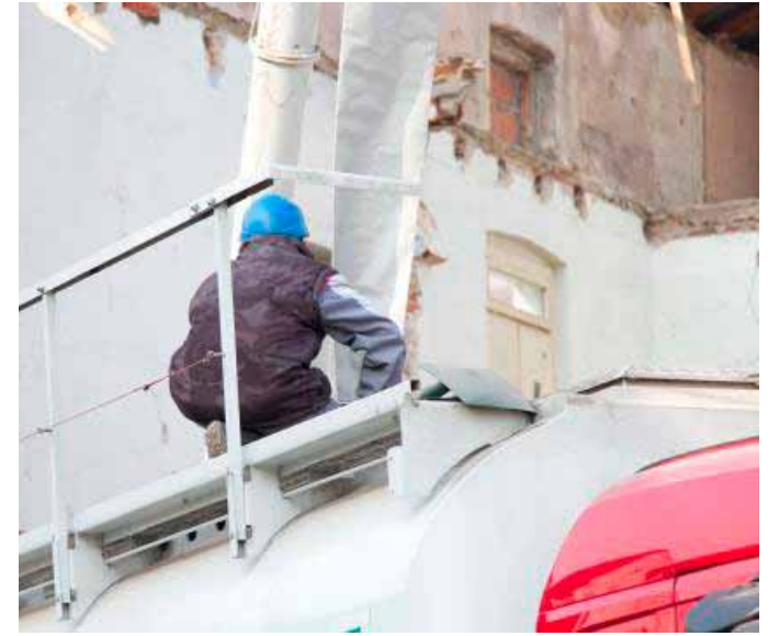
Gli addetti specializzati al lavoro per la rimozione del camion
