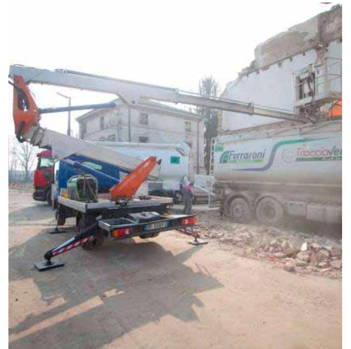
Oggi la messa in sicurezza proseguirà: strada ancora chiusa
