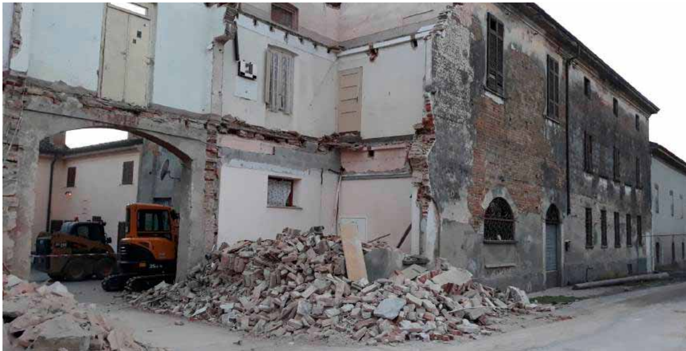
ALLA FINE: ed ecco l'edificio nel pomeriggio, con il camion rimosso, ormai ridotto ad un ammasso di mattoni (foto Studio B12)
