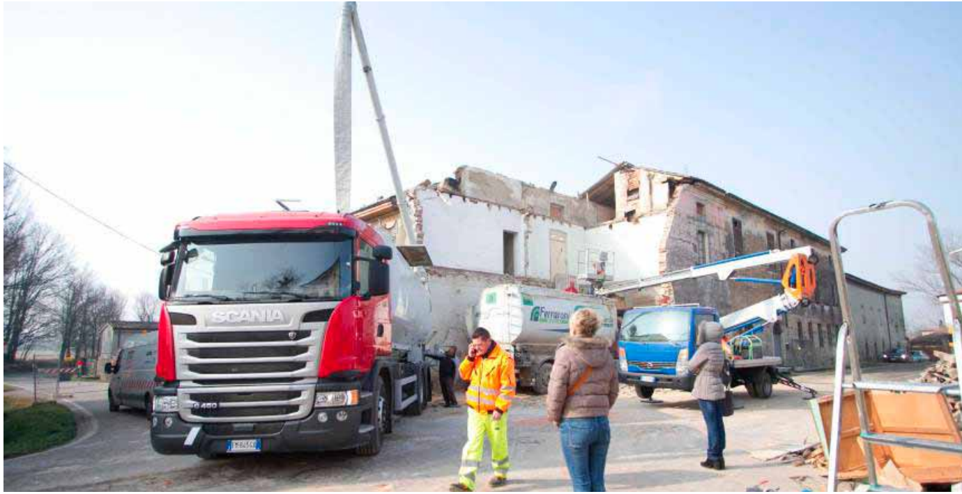
ALL'INIZIO: ecco come si presentava ieri mattina l'edificio, al principio della seconda giornata di demolizione, col camion ancora incastrato nel muro
